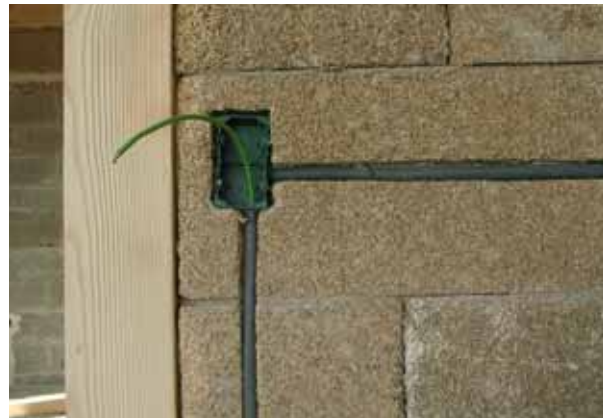
Tracce impianto elettrico e idraulico su Biomattone®
