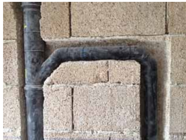
Tracce impianto elettrico e idraulico su Biomattone®
